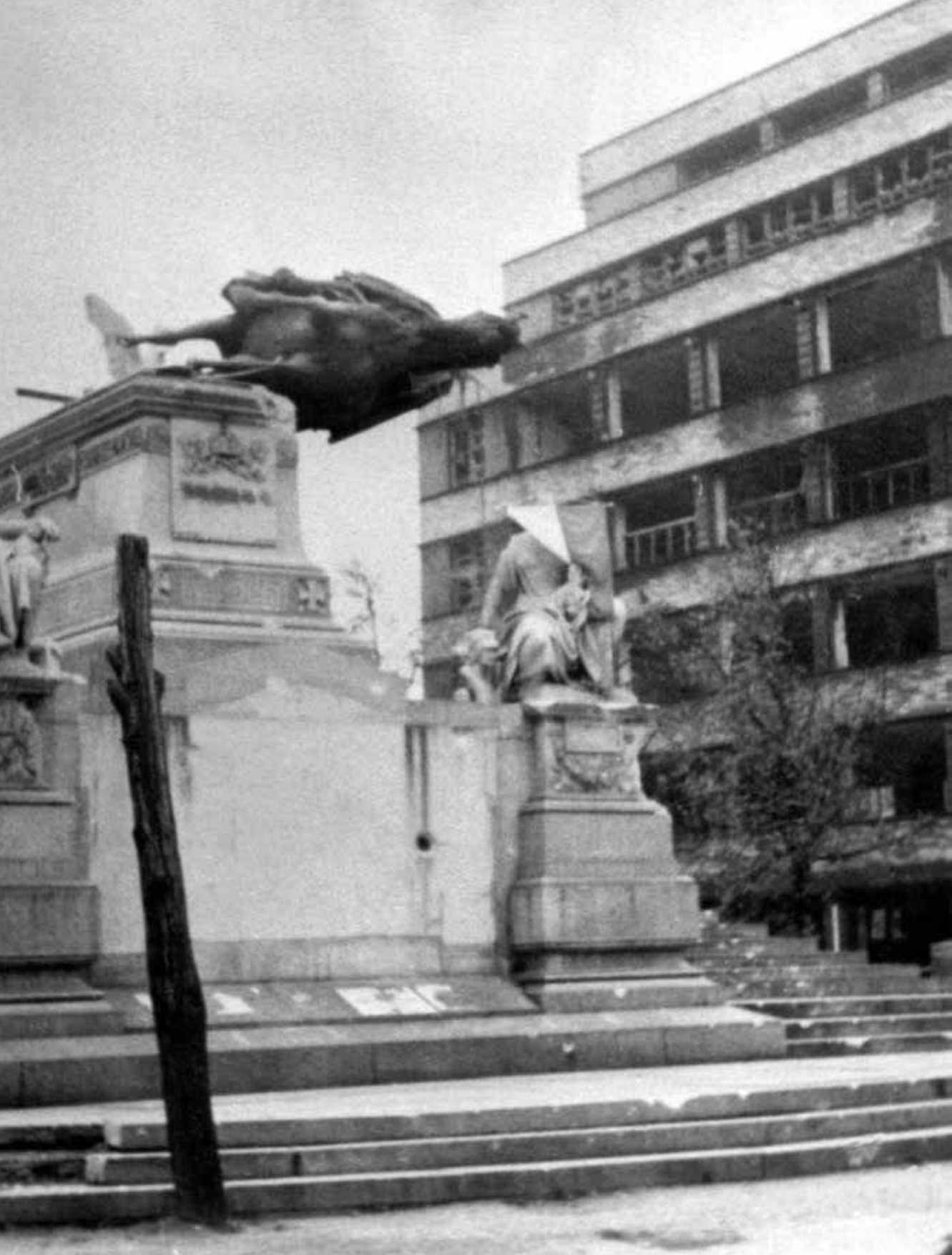
Wyburzenie pomnika cesarza Wilhelma I, Wrocław, 21 X 1945, fot. Zakład Narodowy im. Ossolińskich we Wrocławiu.
